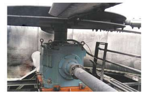
冷却水塔用直角轴齿轮箱
