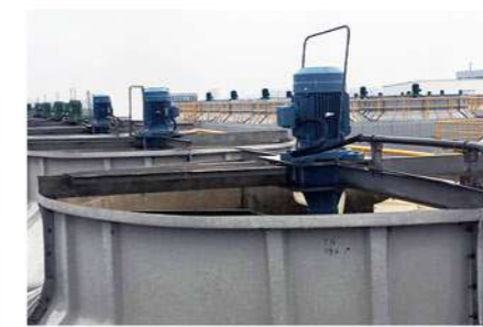
冷却水塔用定制行星减速机
